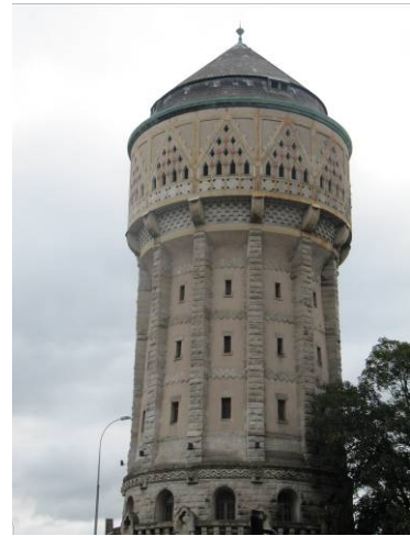
L'ancien château d'eau
